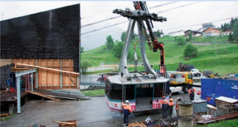
Frühling 2007: Die Umgebung der Talstation ist eine Baustelle. Die Kabinen werden demontiert.
