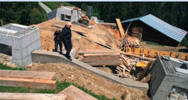
Die Baukommission besichtigt die Stützenfundamente der Stütze 2.
