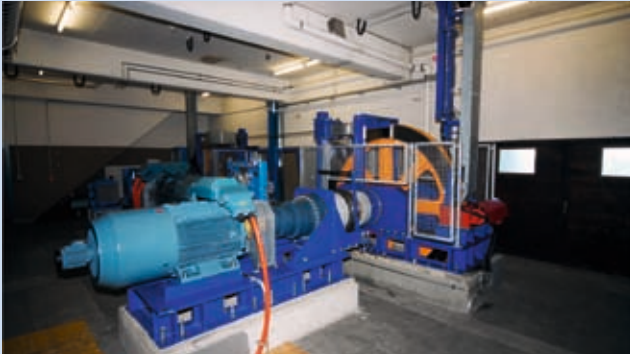
Der Antrieb der Bahn: Der Hilfsantrieb ist direkt mit dem Antriebsrad verbunden.
