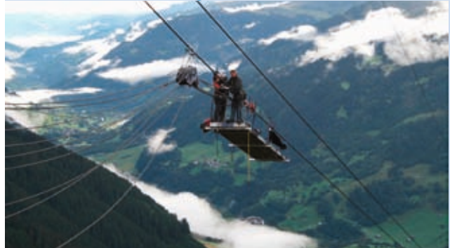
Luftiger Arbeitsplatz: Spannen der Tragseile unterhalb der Bergstation.
