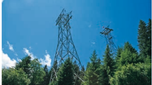
Kurze Zeit hatte Disentis «Twin Towers»: Die alte (1970 40m in der Längsachse falsch gebaute) und die neue (am richtigen Ort) Stütze 1 nebeneinander.
