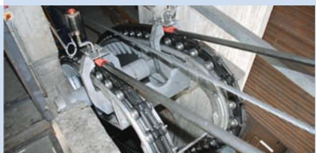
Die Rollenkettsättel in der Talstation wurden revidiert und werden weiter eingesetzt.
