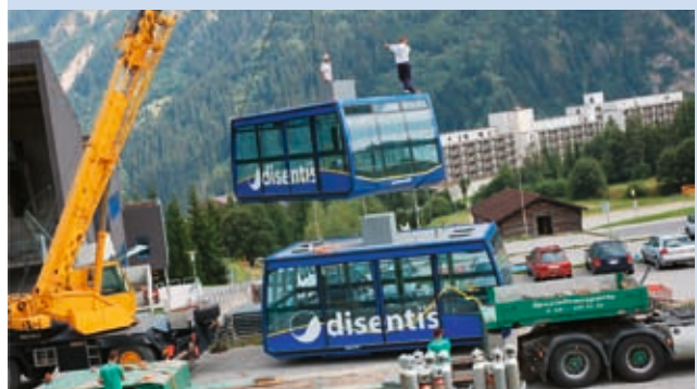
Die neuen Kabinen werden abgeladen.
