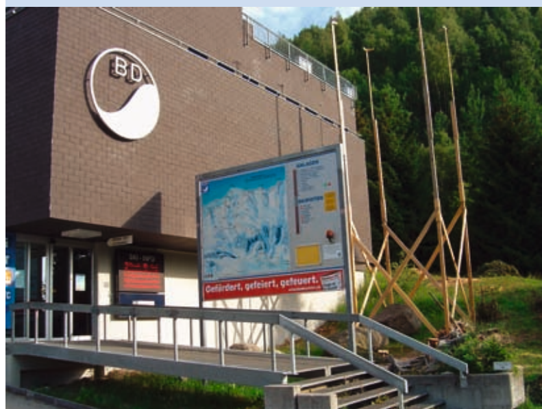
Start des Projektes 2005: Profilierung des Personenliftes für die Talstation.
