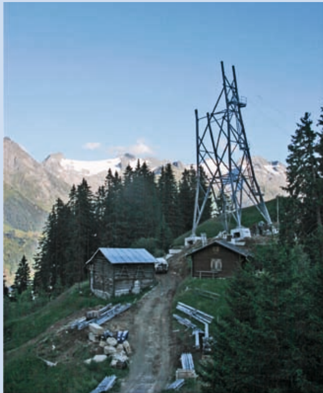
Die Stütze 2 wächst wieder in den Himmel.
