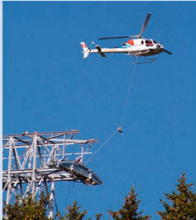
Heikle Arbeit: Der Helikopter legt das Hanfseil zum Vorseilen über die Seilsättel auf der Stütze.
