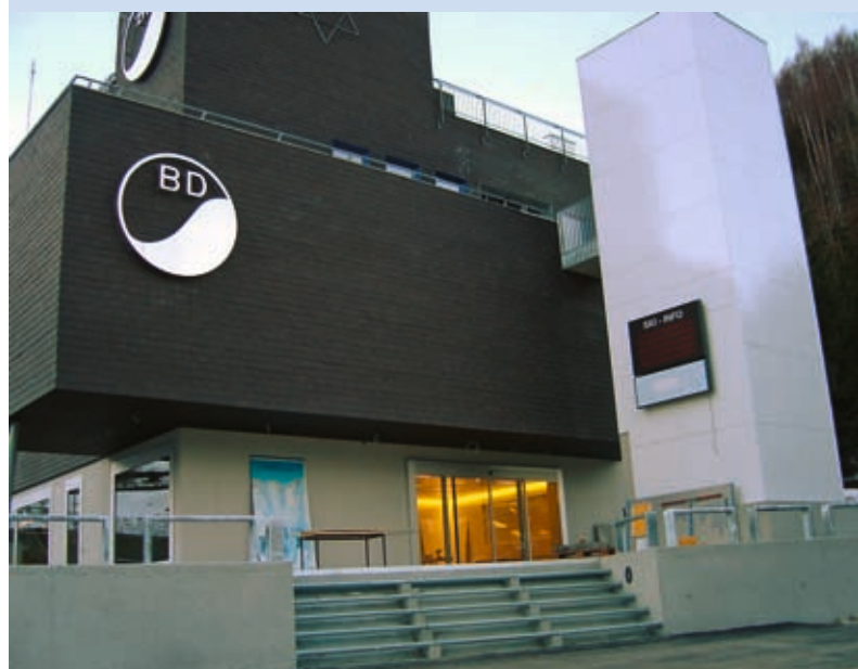
Die bestehende Talstation überzeugt nun mit einem modernen Erscheinungsbild und einem Personenlift.
